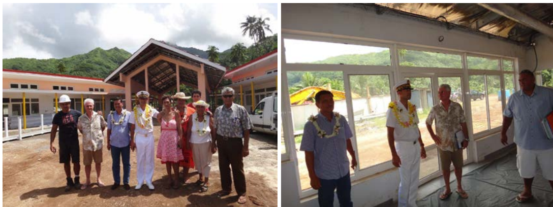
Visite du chantier de l'école de Puohine
